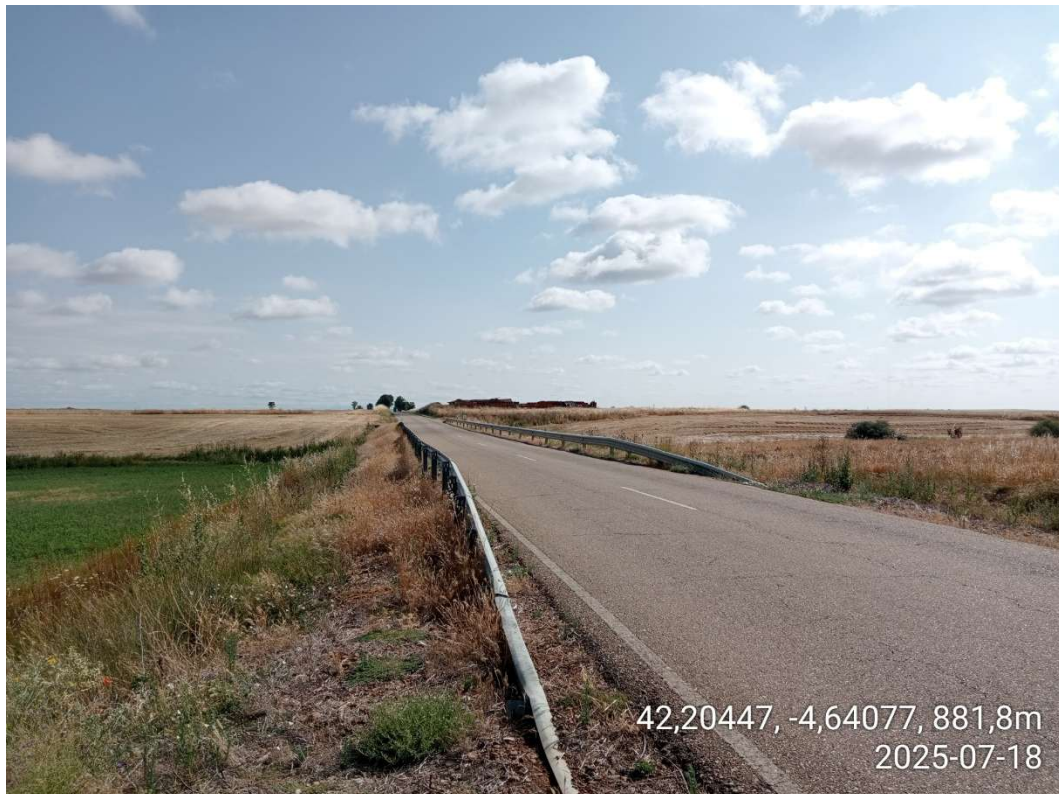
Carretera P-961 que da acceso a las instalaciones del Proyecto Híbrido Eólico-Solar "Alcornoque"
